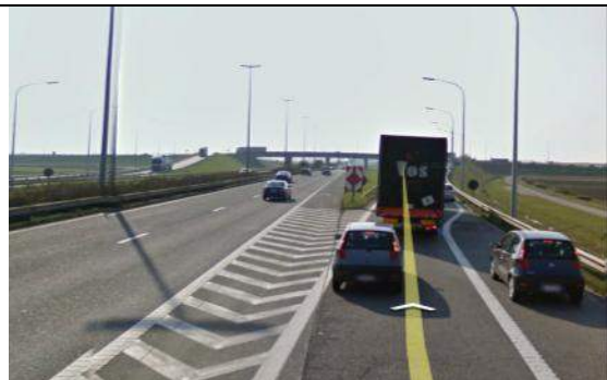
6) Zicht voorwaarts vanuit de file op de uitvoegstrook kort bij de betonpunt: hier is te zien hoe sommige weggebruikers gebruikmaken van de pechstrook.
