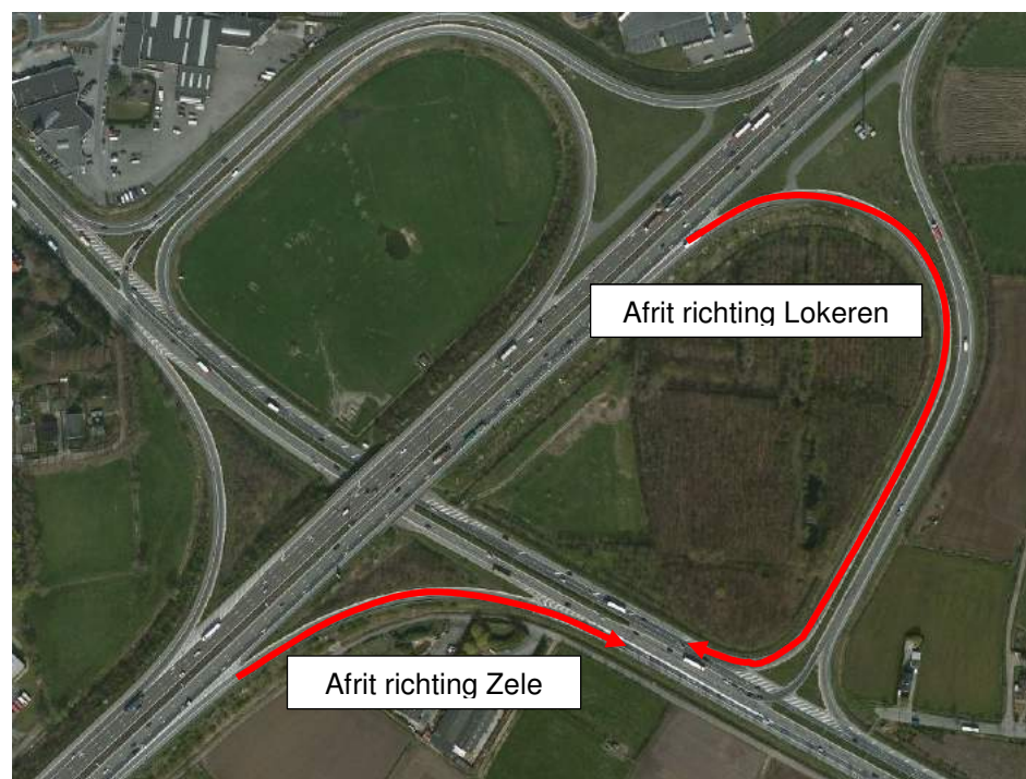
Op- en afrittencomplex Lokeren (E17): ontdubbelde afrit richting Antwerpen
